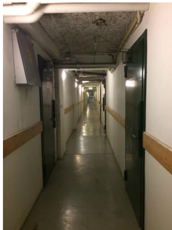
Källare tidigare belysning
